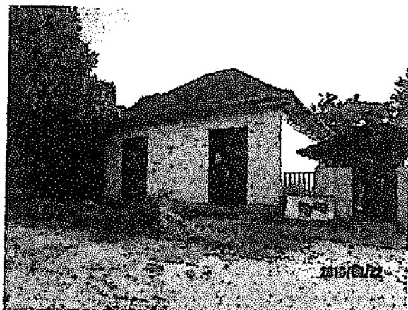
A telken lévő transzformátorház
